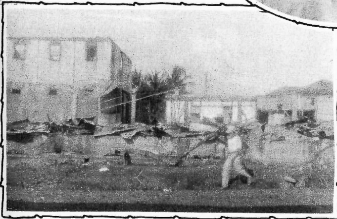
ANTILLA.—Ruinas de siete casas destruidas por un voraz incendio en la ciudad de Antilla. En ese incendio se perdieron totalmente los establecimientos de Peña e Hijo y de Manuel César.
